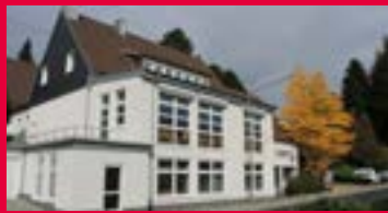
Ev. Gemeindezentrum Büschergrund Mühlenstr. 25
