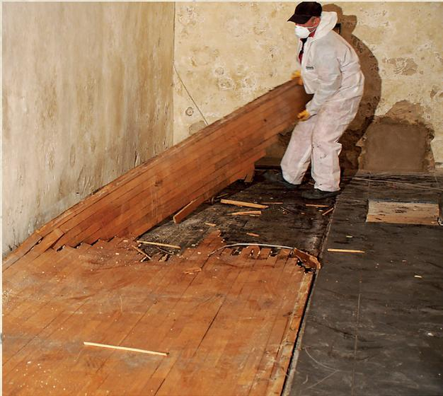
*Um an den Säulen vernünftig arbeiten zu können und um die Lüftungsrillen für die neue Belüftung einzubauen, muss das alte Parkett entfernt werden.*
