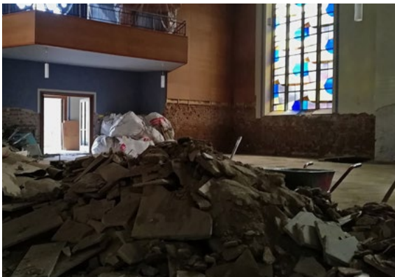
Das Innere der Martin-Luther-Kirche nach Beendigung der Räumungsarbeiten, vor Entfernung von Grundplatte, Altar und Putz
